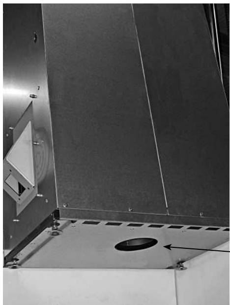
Luchttoevoer-aansluiting onderzijde toestel
